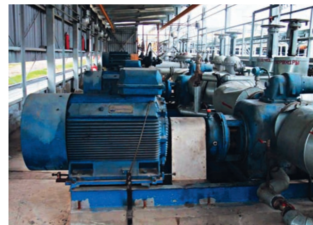
Двухвинтовые насосы HOUTTUIN серии 236 для налива мазута в танкер, терминал пол.г. Азов.
