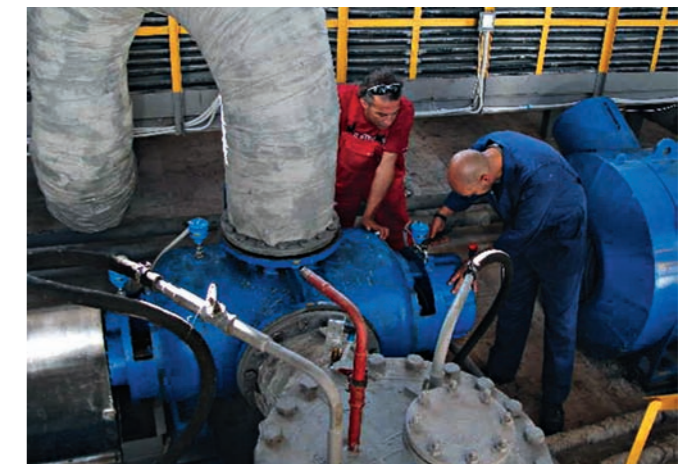
Пуско-наладка двухвинтовых насосов HOUTTUIN для разгрузки ж/д цистерн мазута и налива в танкер на нефтяном терминале, г. Севастополь.
