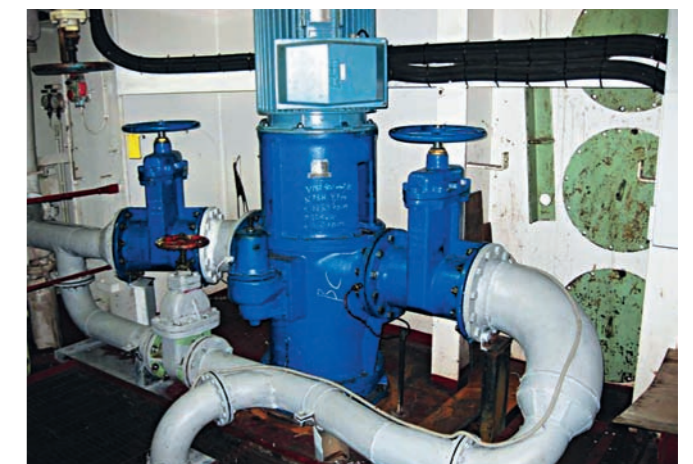
Вертикальный насос HOUTTUIN серии 231 для разгрузки нефтепродуктов на плавтерминале, г. Мурманск.
