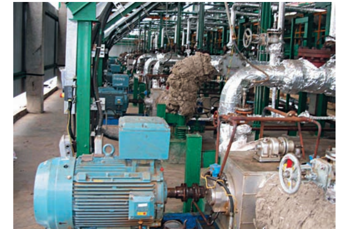
Монтаж-наладка двухвинтовых насосов HOUTTUIN на установке автоналива битумов и мазута, ЯНОС.
