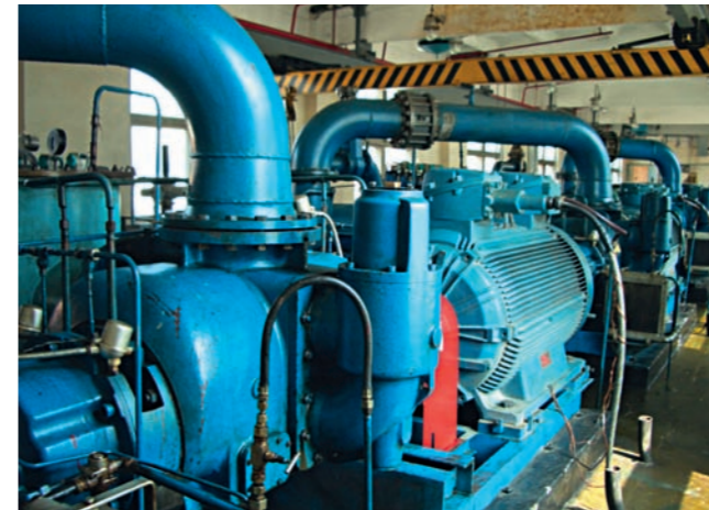
Двухвинтовые насосы HOUTTUIN серии 249 для разгрузки ж/д цистерн мазута, Дальний Восток.
